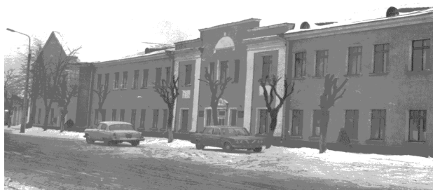
Здание по ул. Лещинской, 2 в г. Гомеле, с которым связаны начало становления будущего университета (фото конца 1970-х годов)
